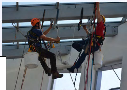
Olomoucké kyvadlo je zavěšeno na žebro střešní konstrukce; horní snímek ukazuje horolezce připevňující závěs v létě 2014. Lanko pak prochází tzv. Charronovým prstencem (1 m pod ukotvením) o průměru 5 cm. Ten má za úkol tlumit případnou elipticitu pohybu kyvadla (částečně „kroužení“), která by narušovala řádné stáčení trajektorie způsobené rotací Země. Ztráty energie způsobené zejména třením o vzduch jsou nahrazovány elektromagnetem pod skleněnou podlahou (na snímku dole). Elektromagnet sepe krátce před tím, než se kyvadlo vrátí do rovnovážné polohy a mírně jej postrčí vpřed. Protože je magnet umístěn středově symetricky, nemá vliv na stáčení roviny kyvu.
